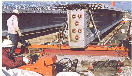
※橋梁桁横取装置
