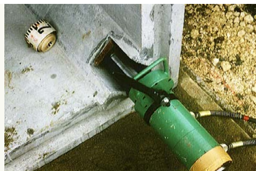
※35t×100 センターホールジャッキ PC鋼棒緊張機
